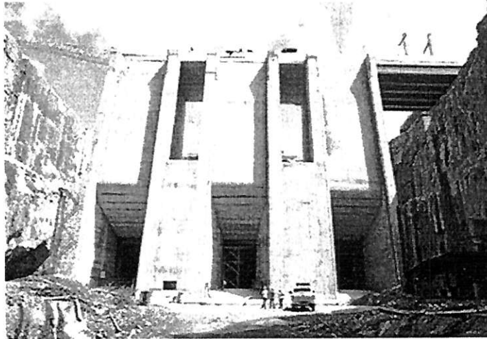
Nos condutos forçados, falta apenas a concretagem da parte que faz a transição entre os trechos horizontal e sub-horizontal em uma das três unidades
