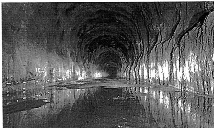
Túnel de baixa pressão foi escavado em um único nível por 1,92 km
