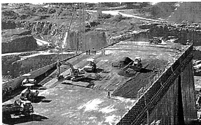
As camadas são colocadas com pequena inclinação de 10% com relação à horizontal de modo a permitir o acesso do rolo
