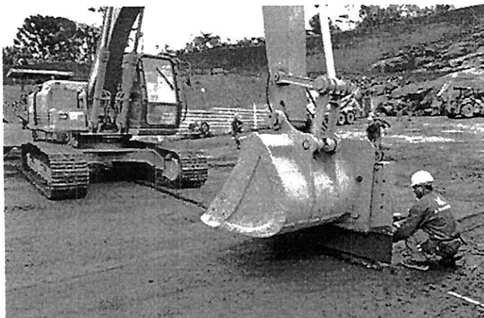
Escavadeira foi adaptada para execução das juntas, trocando a parte da concha por uma chapa metálica. Equipamento fazia o corte do concreto já compactado para permitir a indução da junta
