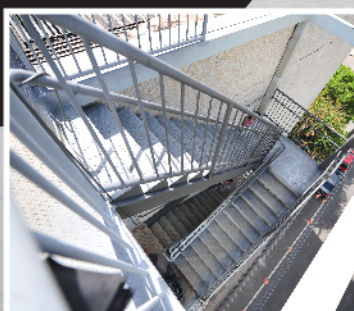
▶ Escada de emergência.
