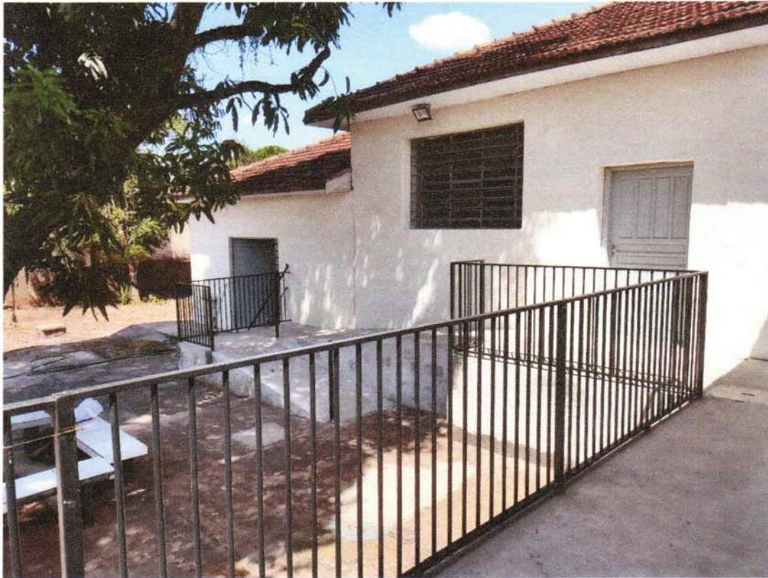
Foto 22: Rampa de acesso.
