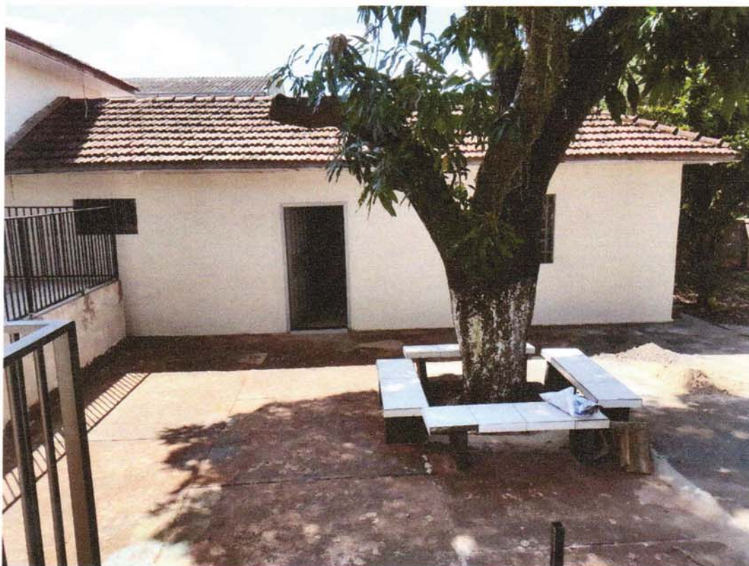
Foto 24: Área de circulação.
