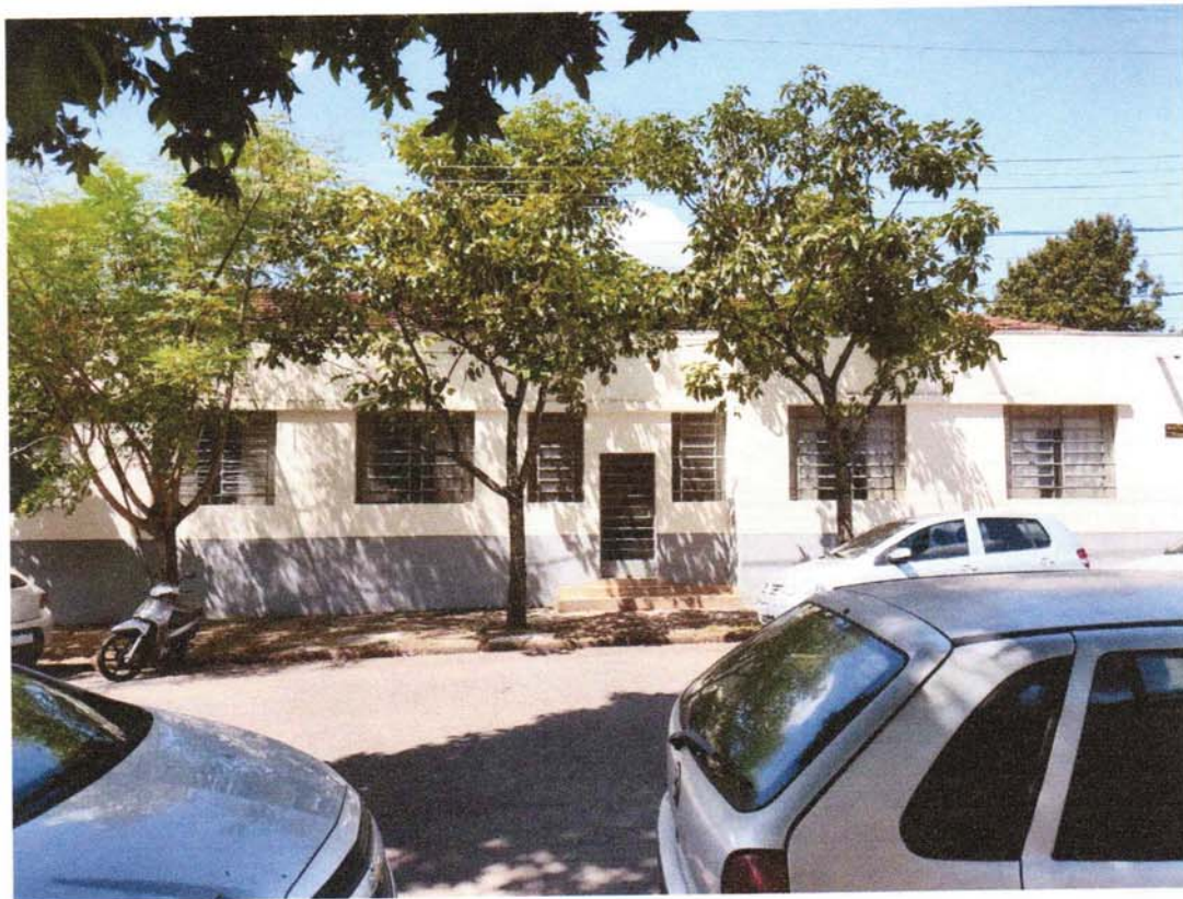
Foto 01: Fachada do imóvel.
