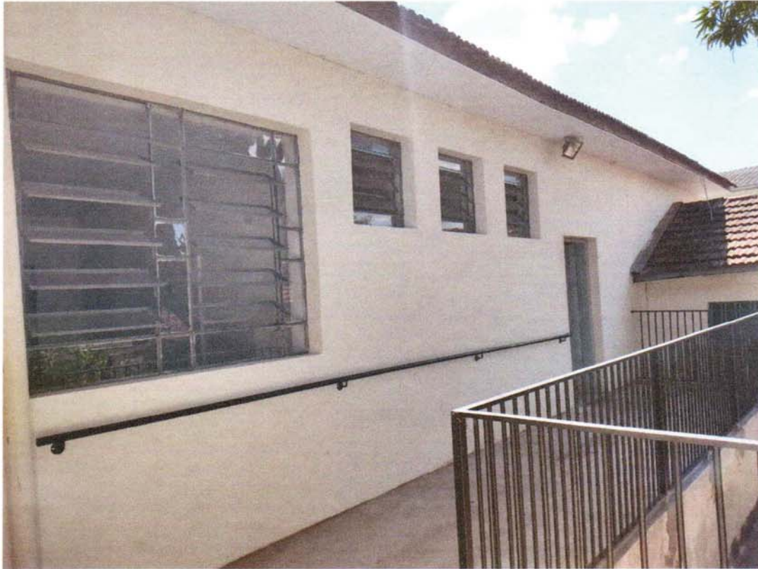
Foto 23: Rampa de acesso.
